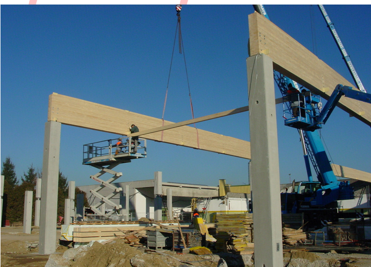
Fotografie: Inspecția Muncii
